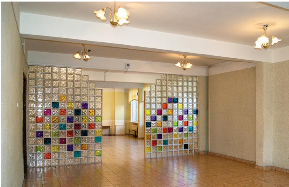
Hallways decorated with colored stained-glass partition – an attempt to divide the space in two zones Рекреация с цветными витражами – попытка зонирования пространства
